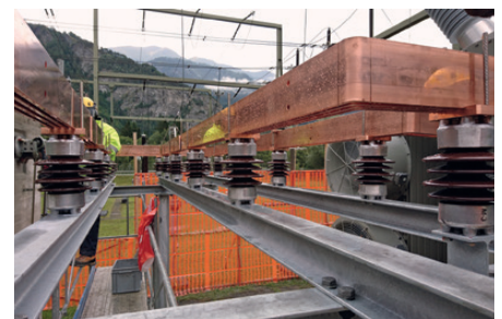
L'arrivée 14 kV en construction
