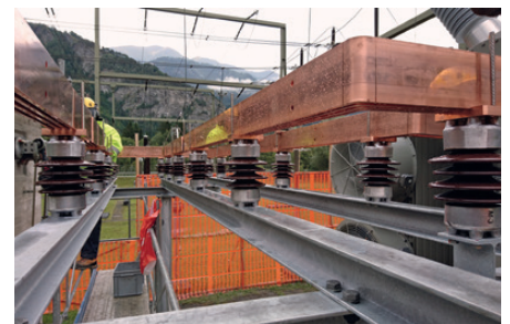
Die 14-kV-Zuleitungen im Aufbau
