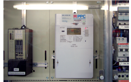
Elster-Zähler AS3000 mit eingebautem BPL-Gateway-Modul 4M
