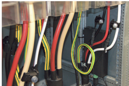
Das BPL-Headend kann an (fast) jedem Ort montiert werden.
