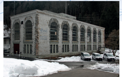
L'impressionnant bâtiment est classé. Les cellules des transformateurs se trouvent à l'arrière du bâtiment.
