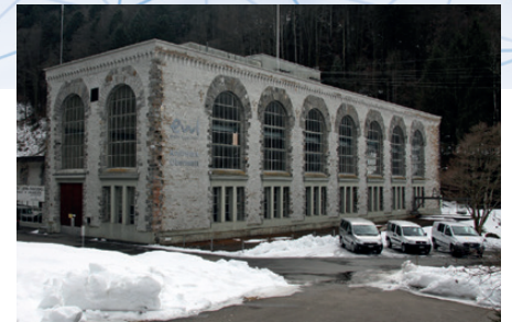
Das stattliche Werksgebäude steht unter Denkmalschutz. Die Transformatorboxen befinden sich auf der Gebäuderückseite.
