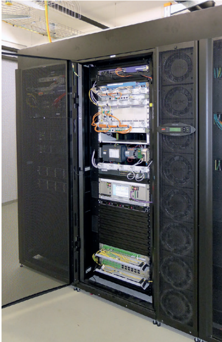
Rundsteuersendeanlage in Sarnen
