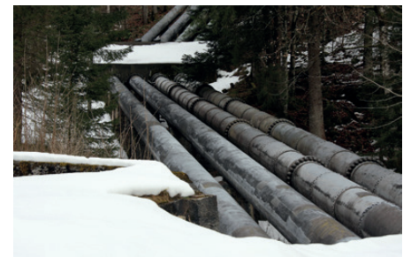
Die fast 100-jährigen Druckleitungen weisen ein Gefälle von 312 Metern auf.
