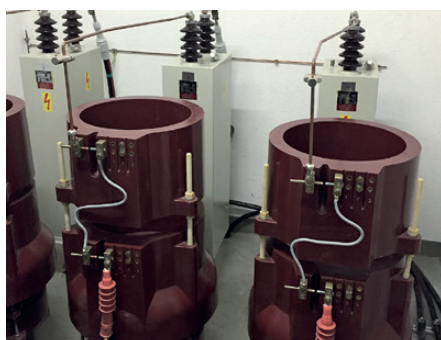
Couplage parallèle rigide transformé au poste Naters
