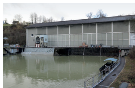
Le local des machines de la centrale de Rheinau: le flux d'eau gauche est bloqué à cause des travaux sur le transformateur.
