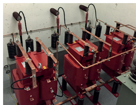
Nouveau couplage parallèle rigide au poste Ernen
