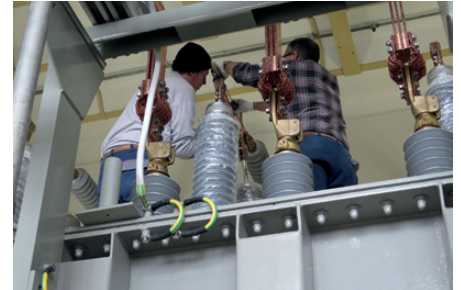
Travaux de montage sur le transformateur
